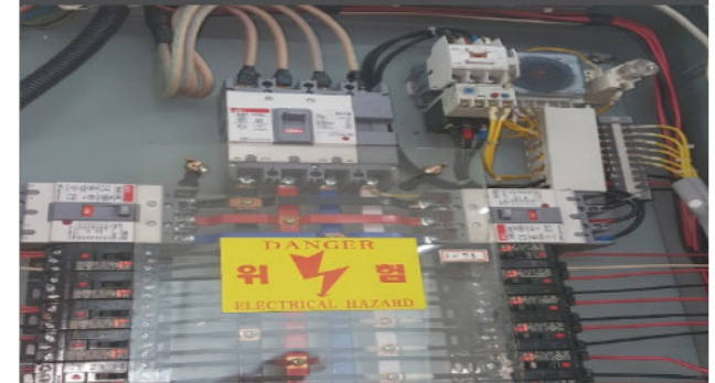
중랑노인전문병원 1층 주방
