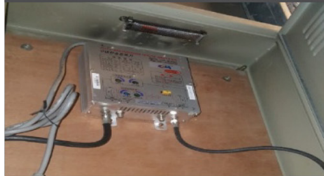
중랑노인전문병원 1층 사무실
